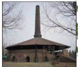
野木町煉瓦窯（国重要文化財）ホフマン式円形輪窯。遊水地の土で煉瓦を製造していた。
